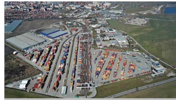
RAIL HUB Terminal DUNAJSKA STREDA (SK)
